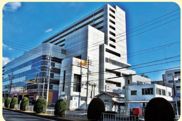
(御器所駅ビル外観写真)
